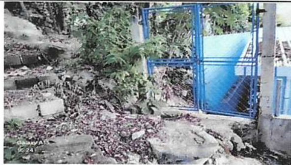
Foto 1: Reparación muro perimetral de block ✓
